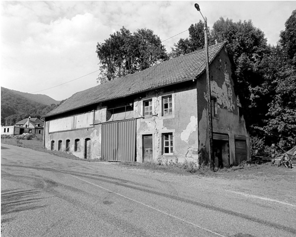
Bâtiment d'eau depuis le sud.
