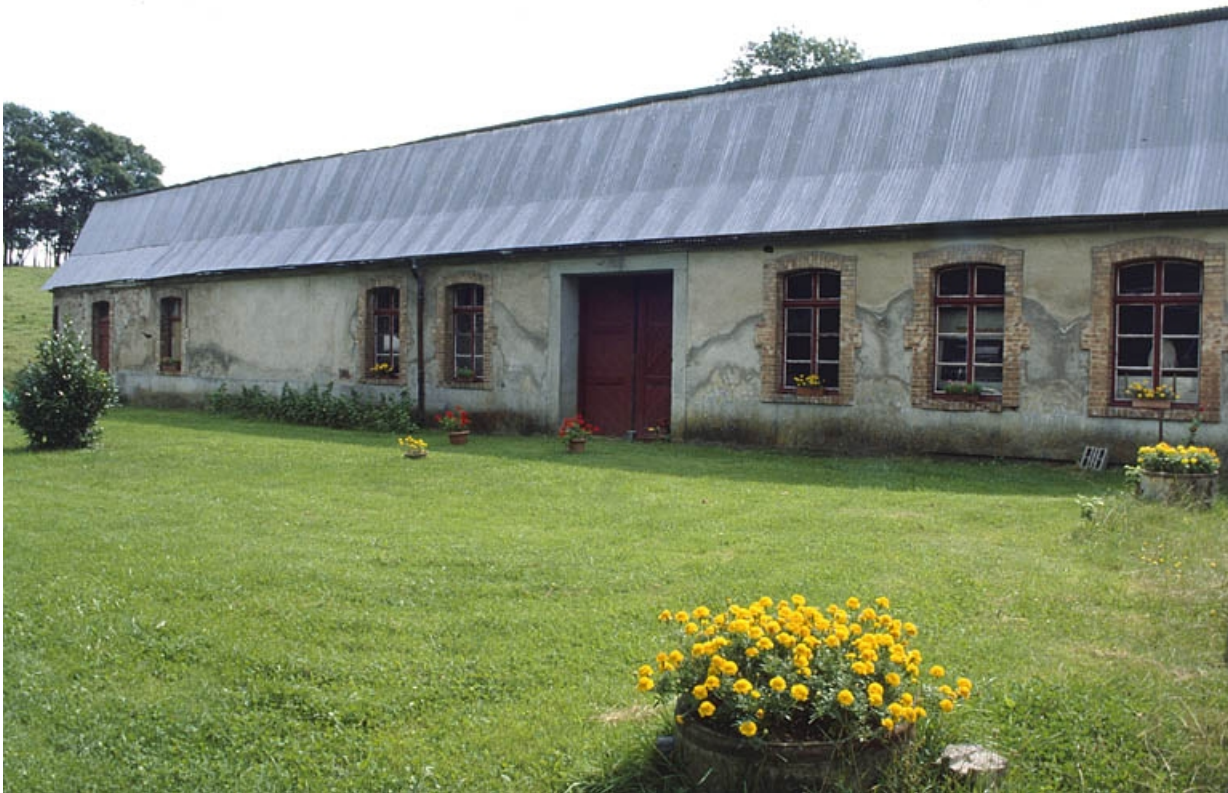
Façade (remaniée) de l'atelier de fabrication.
