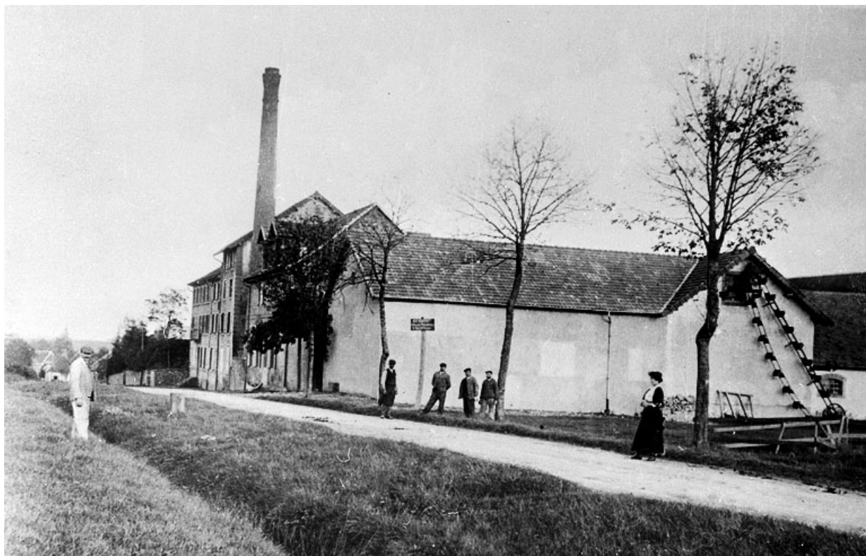
La brasserie depuis l'ouest.
