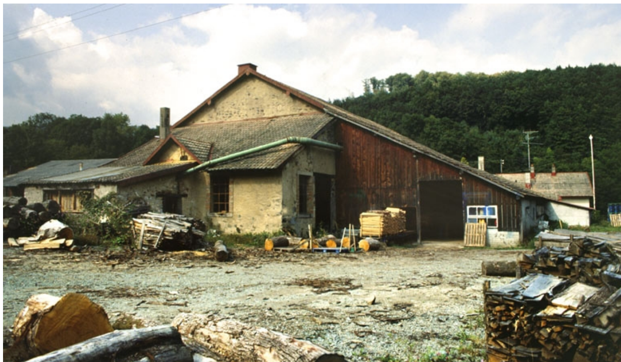
L'atelier de fabrication depuis le sud.
