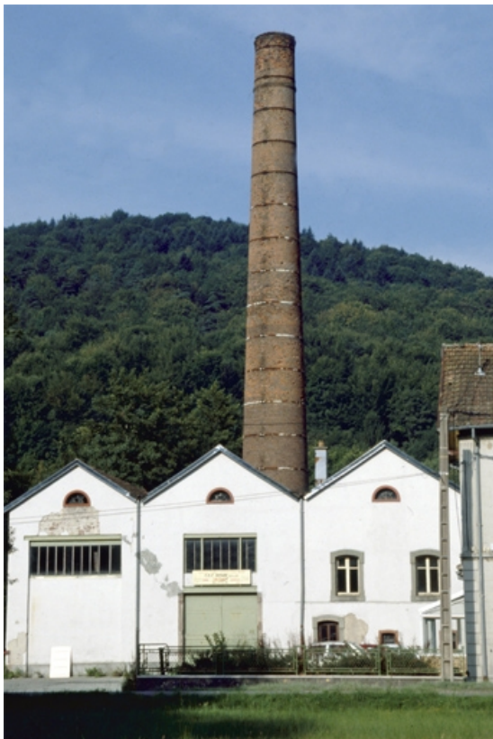
Salle des machines, chaufferie et cheminée.
