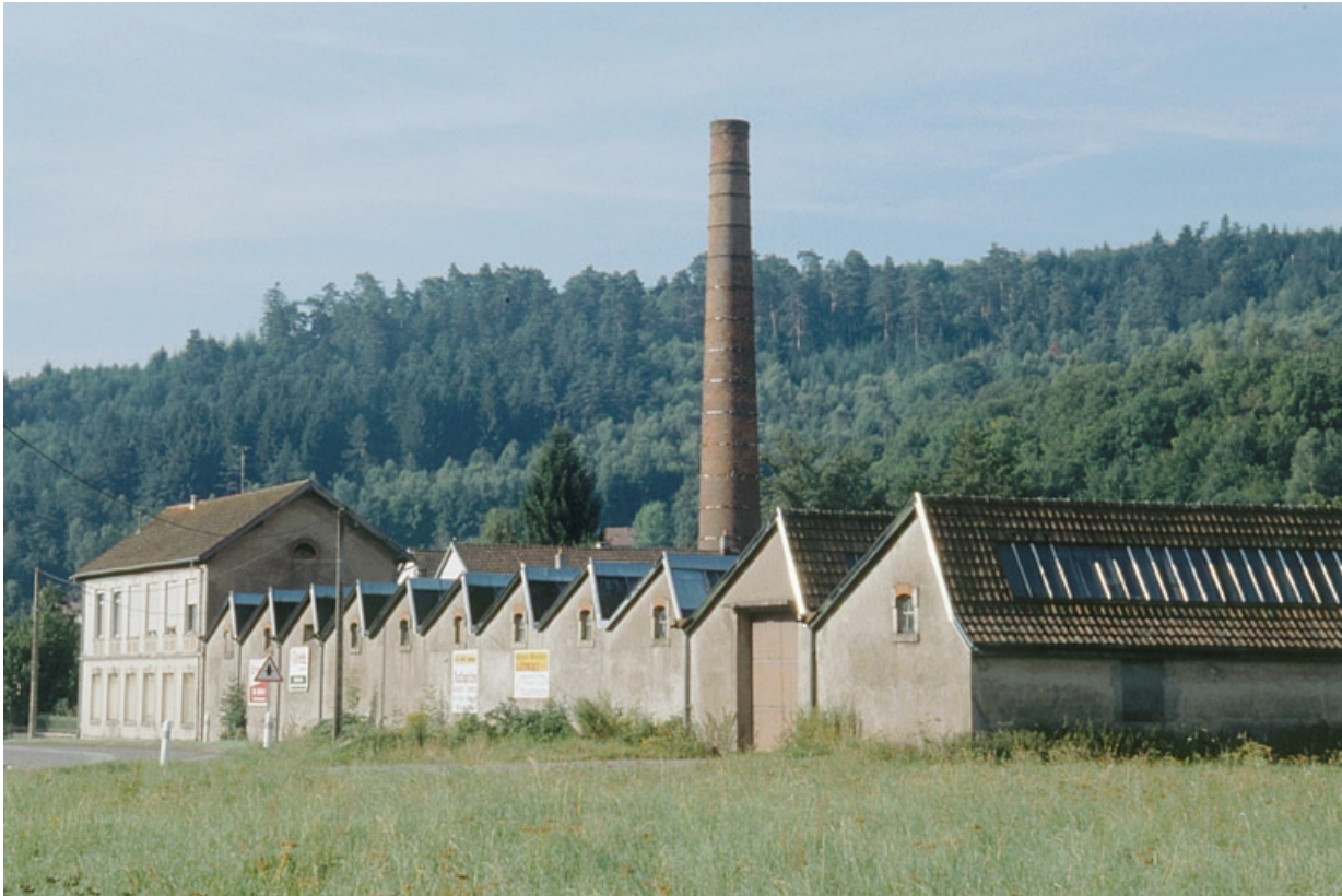
Façade sur la route départementale 465. 90, Lépoux R.D. 465
