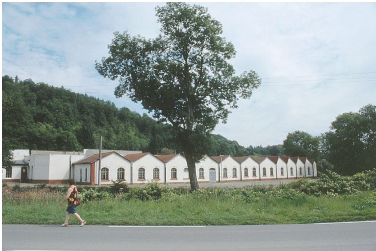
Vue d'ensemble depuis l'ouest.
