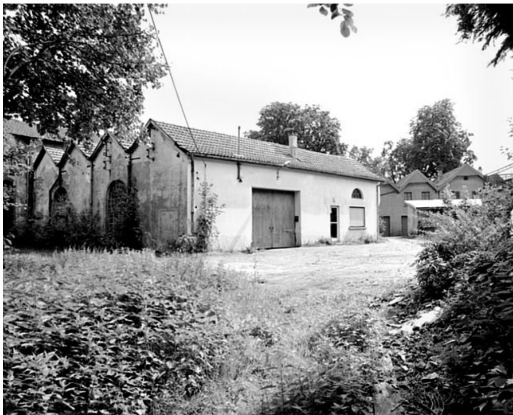
Salle des machines et chaufferie depuis l'ouest.
