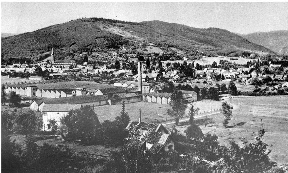
Giromagny. (Territoire de Belfort) - Vue générale.
