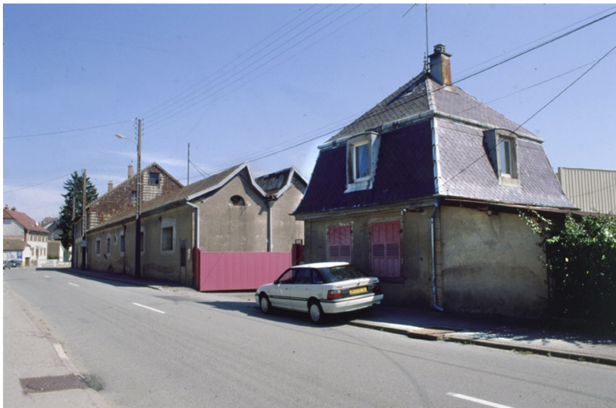
Atelier de fabrication et conciergerie depuis l'ouest.
