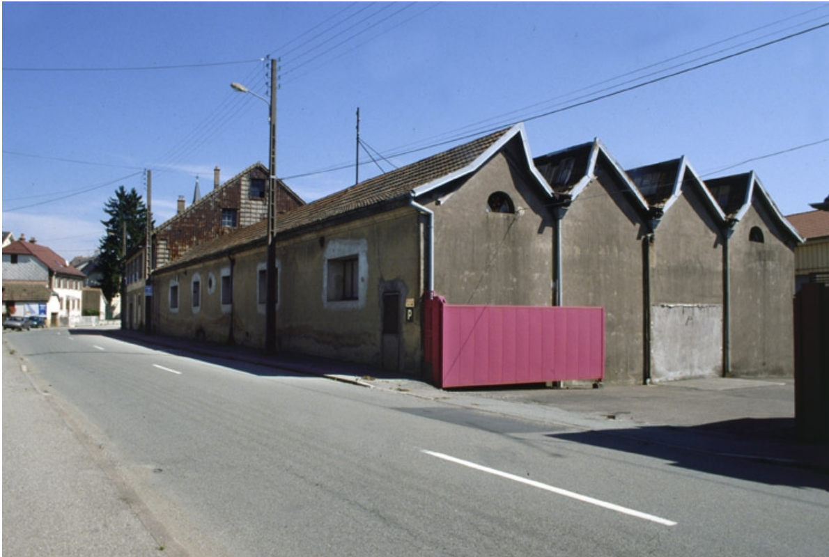
Atelier de fabrication longeant la rue d'Etueffont.
