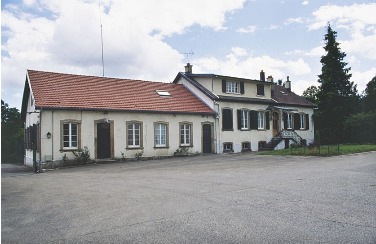
Les bureaux attenants au logement de contremaître.
