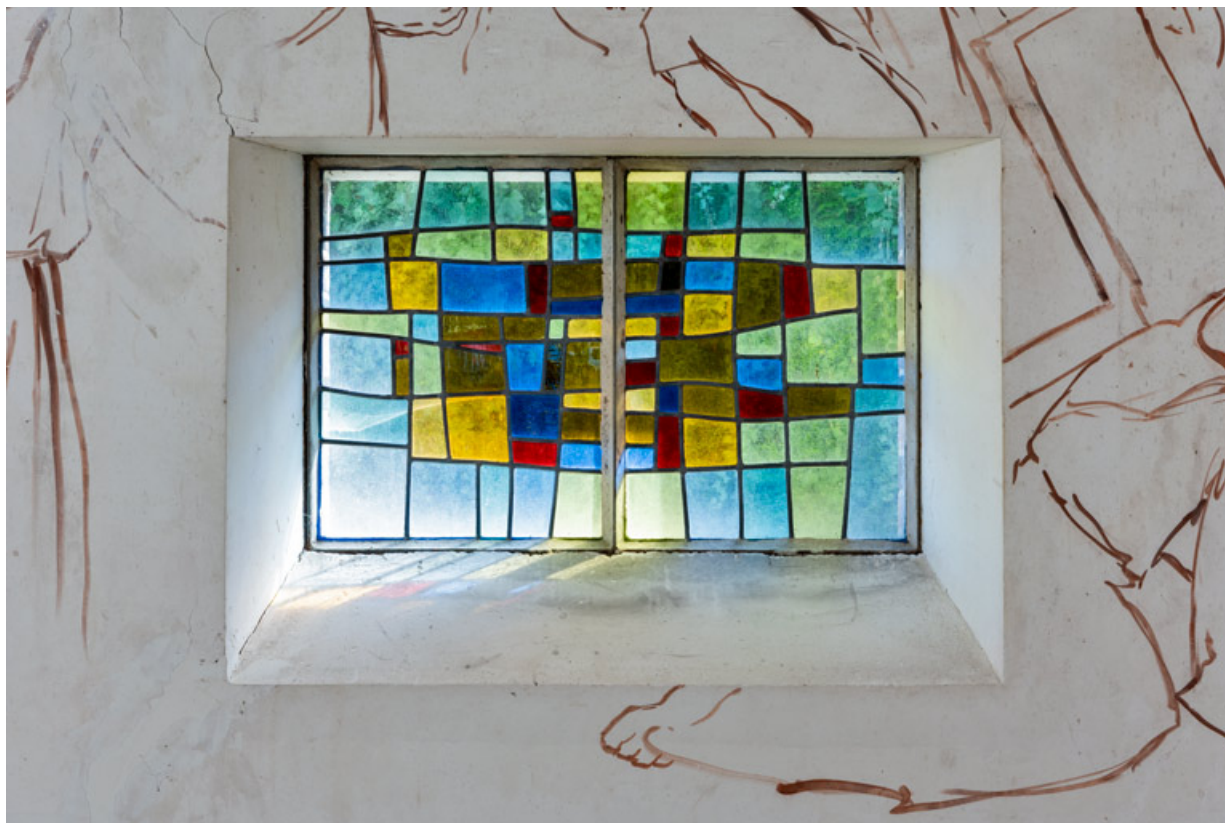
Vue d'une verrière (baie 2).
