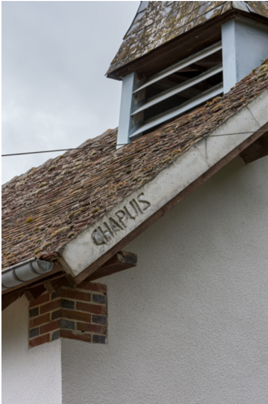
Rampant et rive de la toiture (détail).
