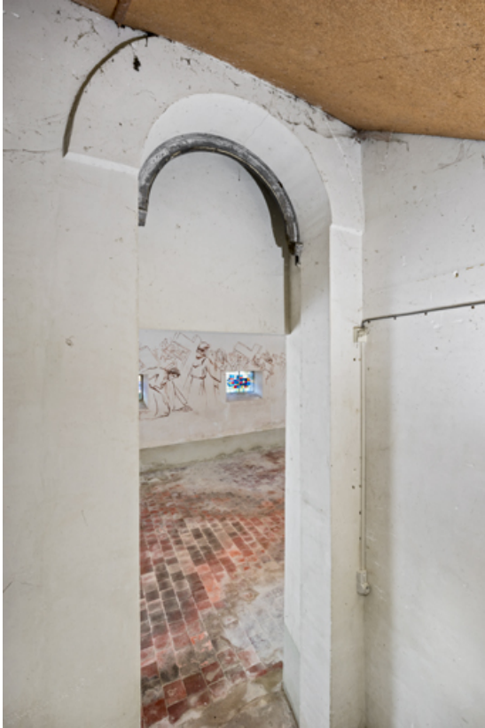
Vue de la baie de la sacristie.
