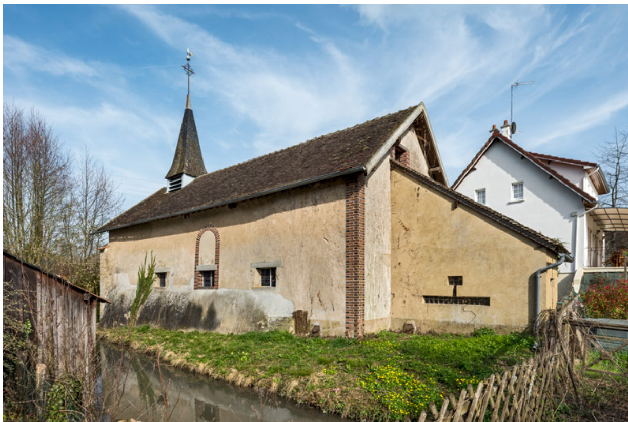
Vue de la façade nord.
