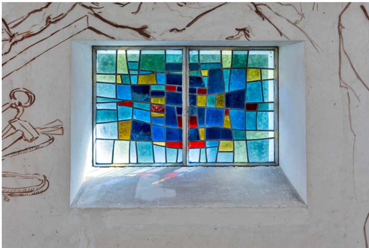
Vue d'une verrière (baie 4).
