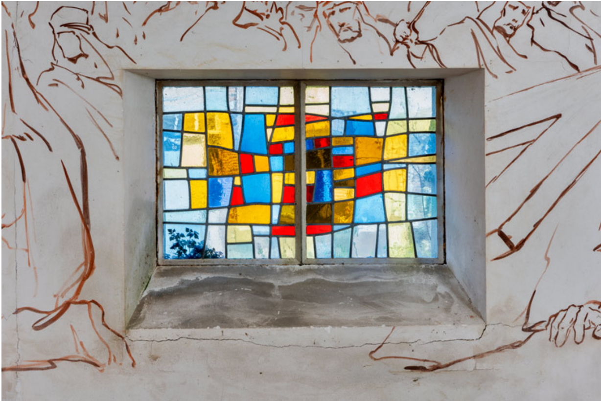
Vue d'une verrière (baie 1).
