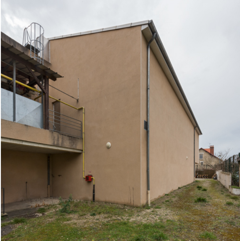
Salle 8, vue du nord.
