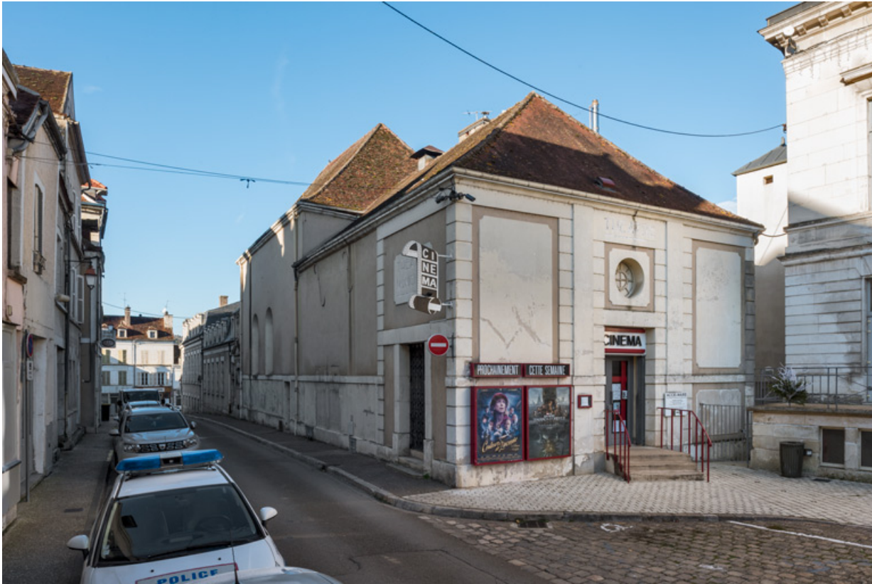
Façades antérieure et latérale gauche.
