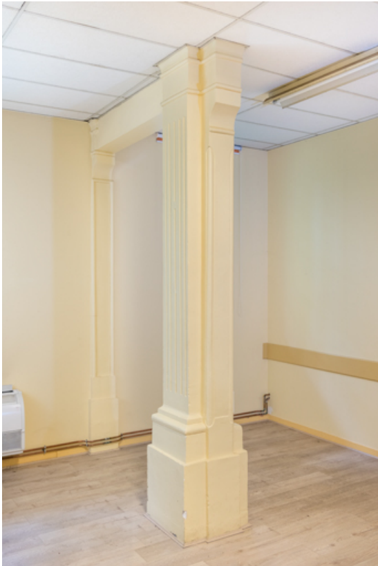
Pilier délimitant l'espace du chœur. Détail.
