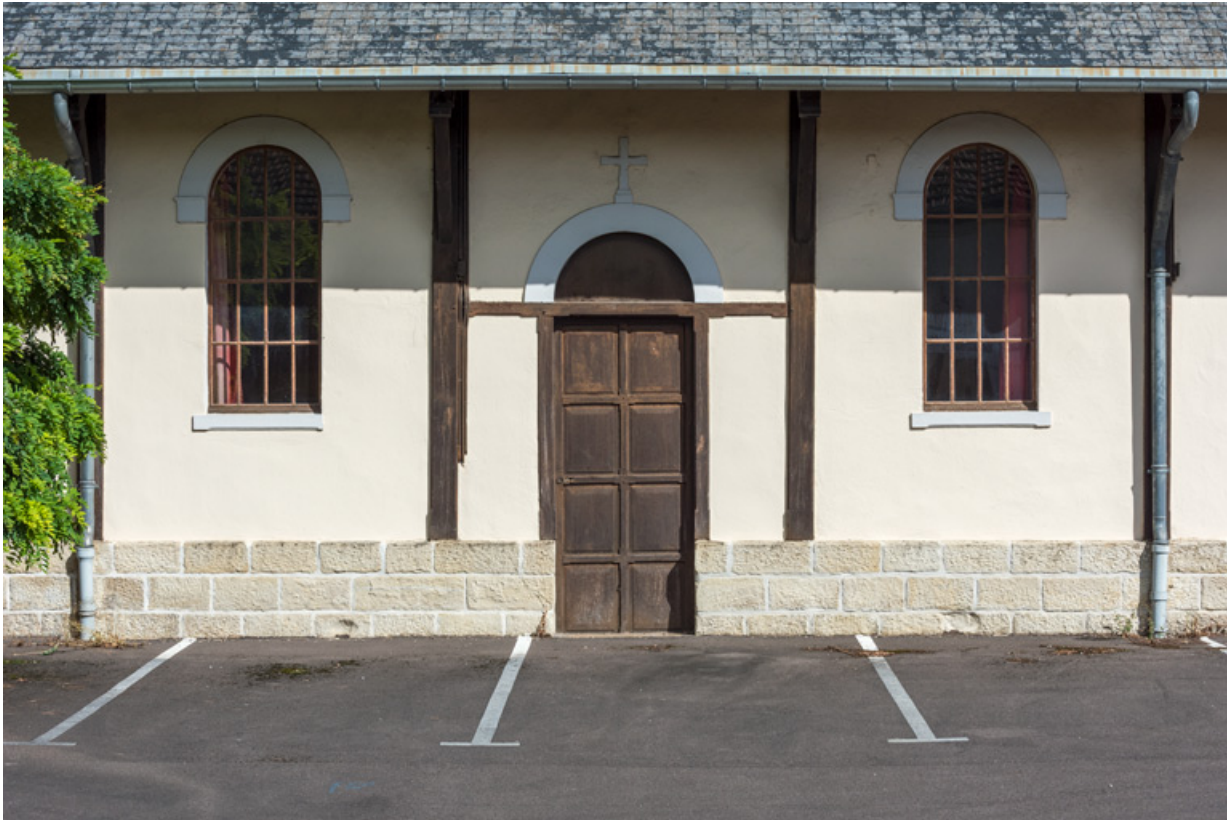
Façade ouest. Vue de trois travées.
