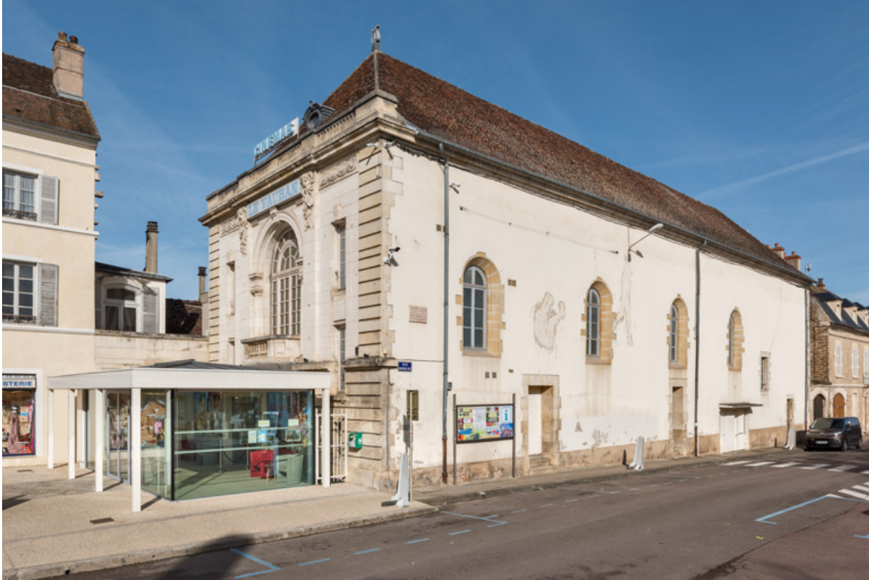
Façades antérieure et latérale droite.
