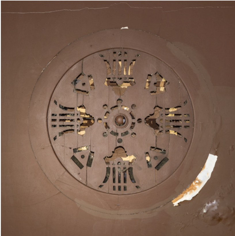
Ancien système d'aération au plafond.
