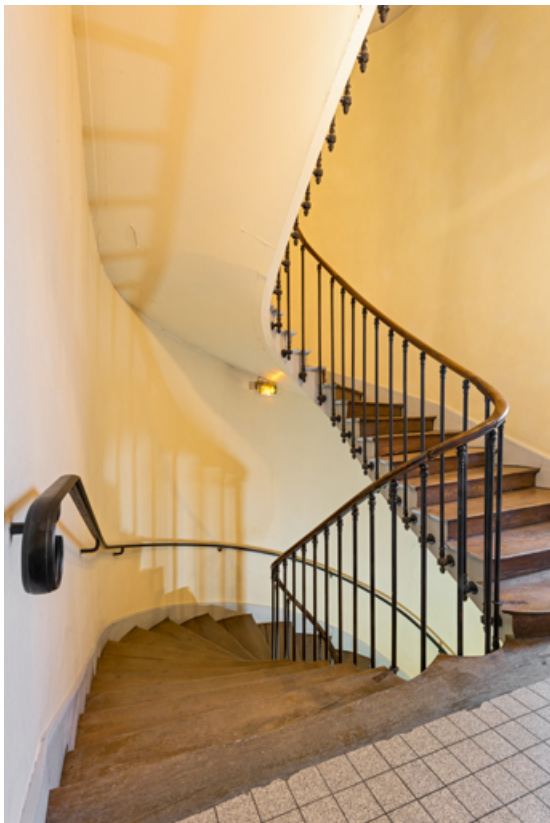
Escalier, au palier de l'étage carré.
