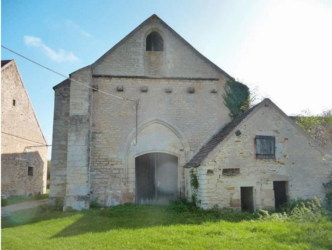
Façade de la chapelle et petite dépendance.
