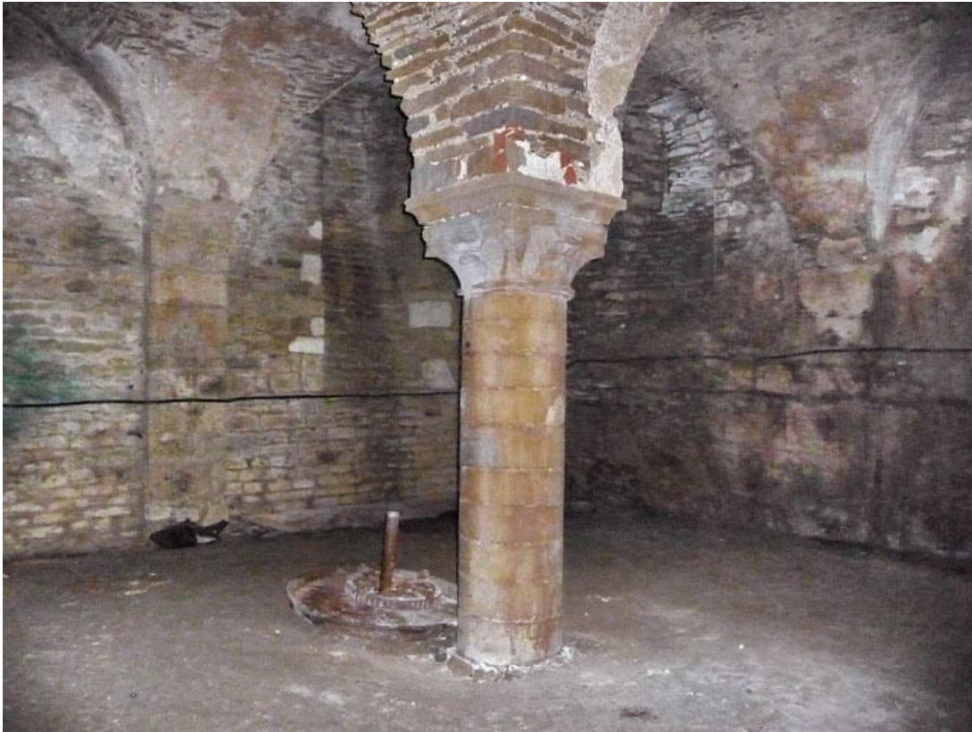
Cave sous la grange, supports des voûtes : pilastre, colonne et culot.
