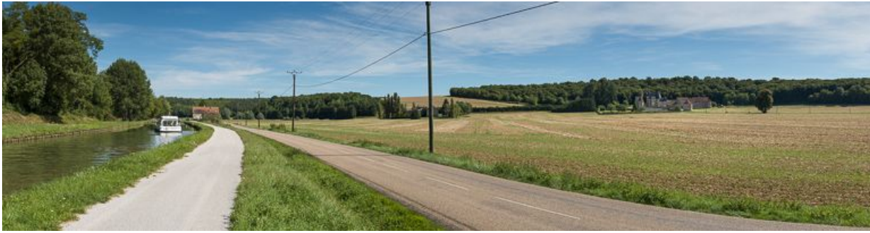
A droite, le château depuis le canal et en arrière-plan, on aperçoit la maison éclésièrre du site d'écluse 55. 89, Lichères-sur-Yonne, lieudit : bief 55 du versant Seine
