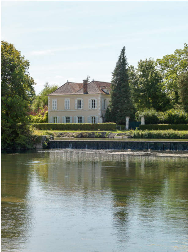
Le château, vu du canal.
