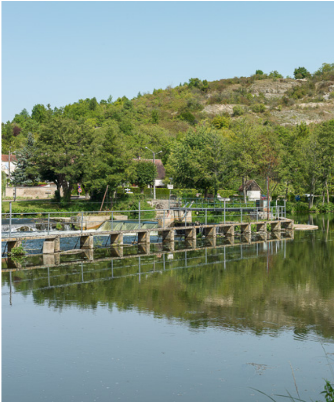
Vue du barrage.
