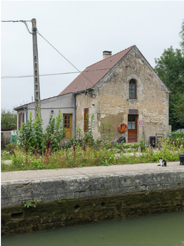
Vue de la maison éclusière.
