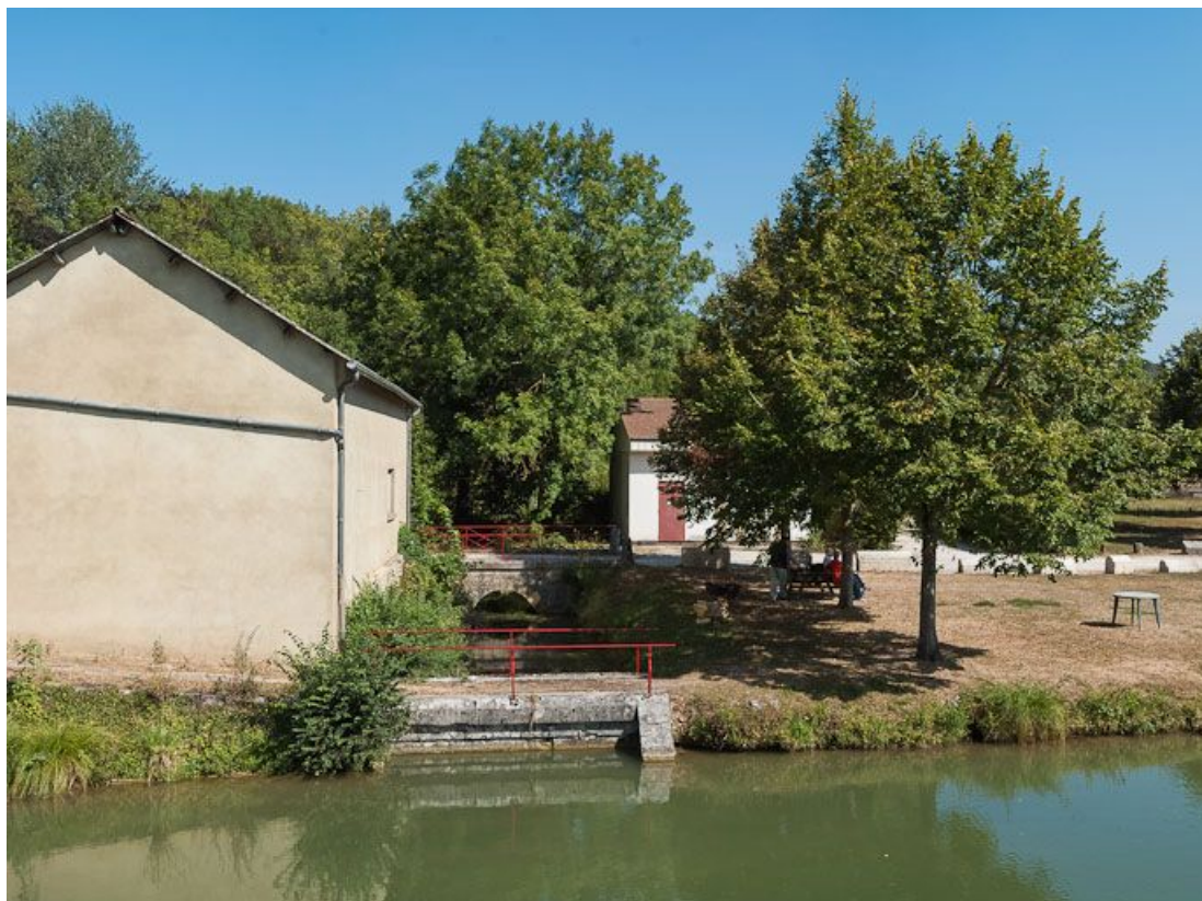
Détail d'un déversoir en aval du port.
