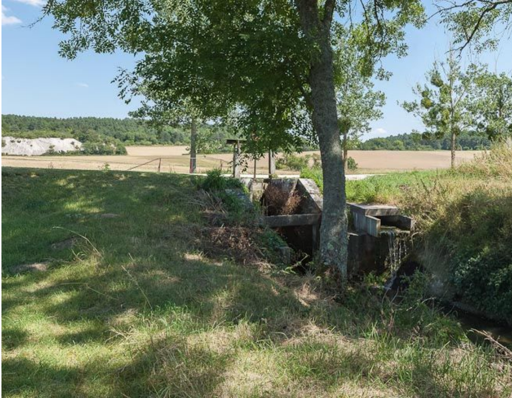
Déversoir avec vanne rive gauche.
