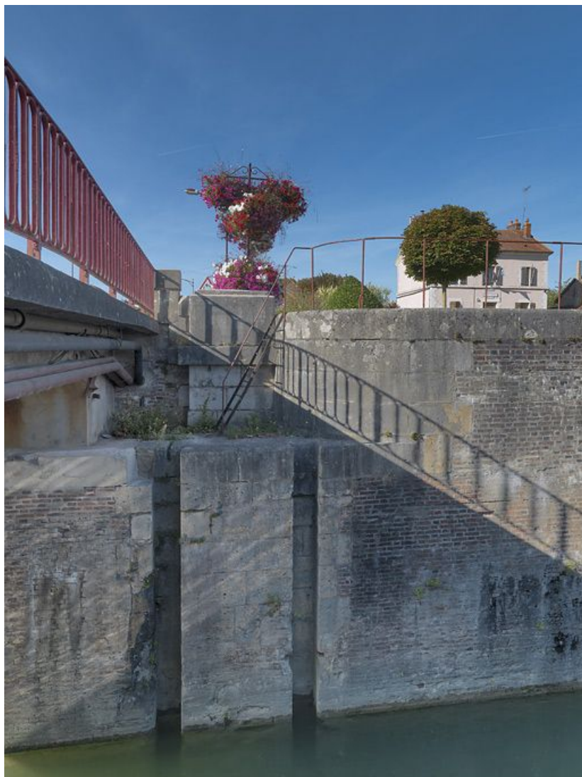
Le pont sur écluse : détail des maçonneries.
