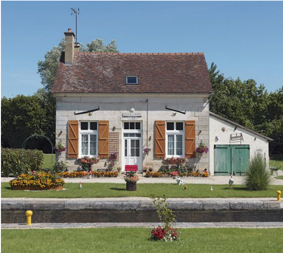
La maison éclusière vue de face.
