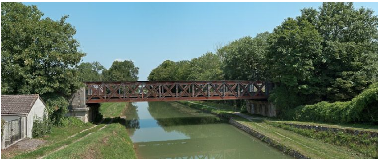
Vue du pont.
