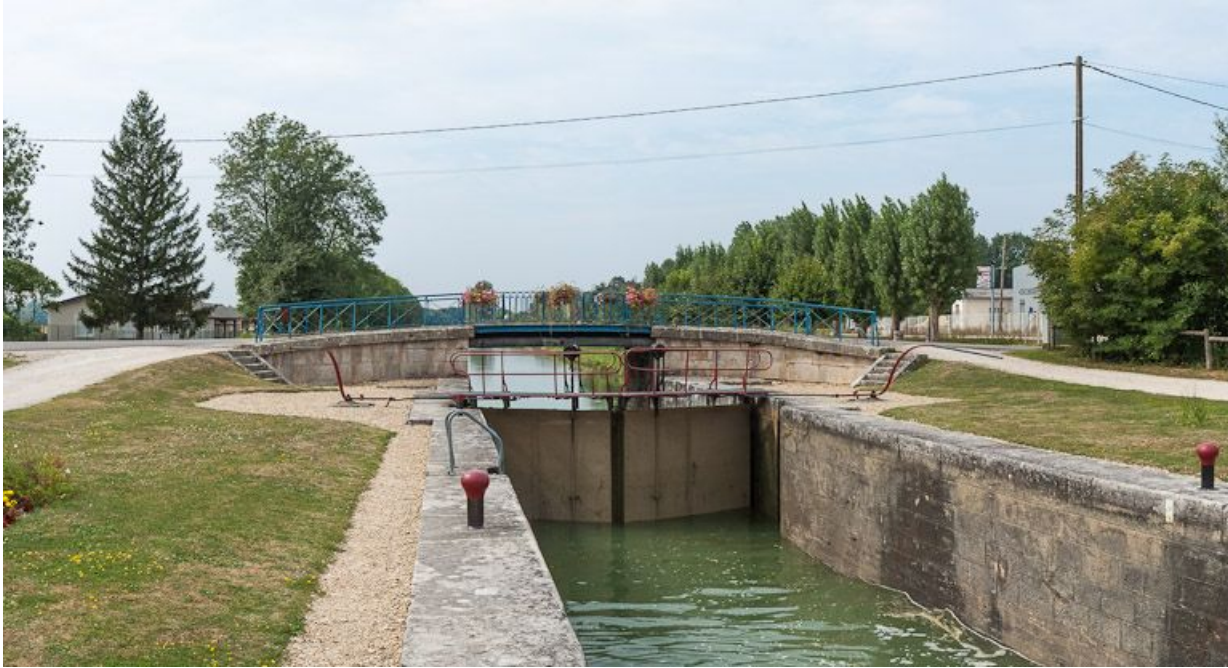
Vue du pont depuis le sas.
