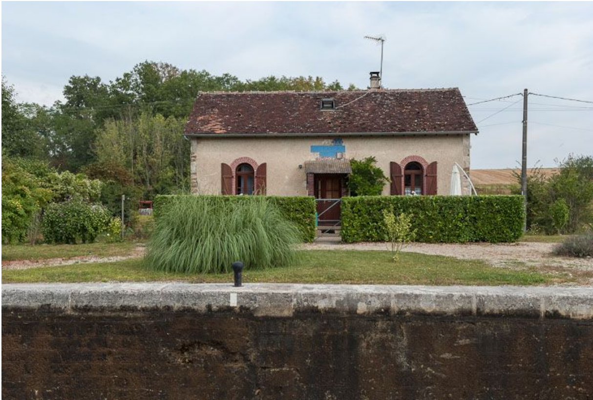
Maison éclusière vue de face.
