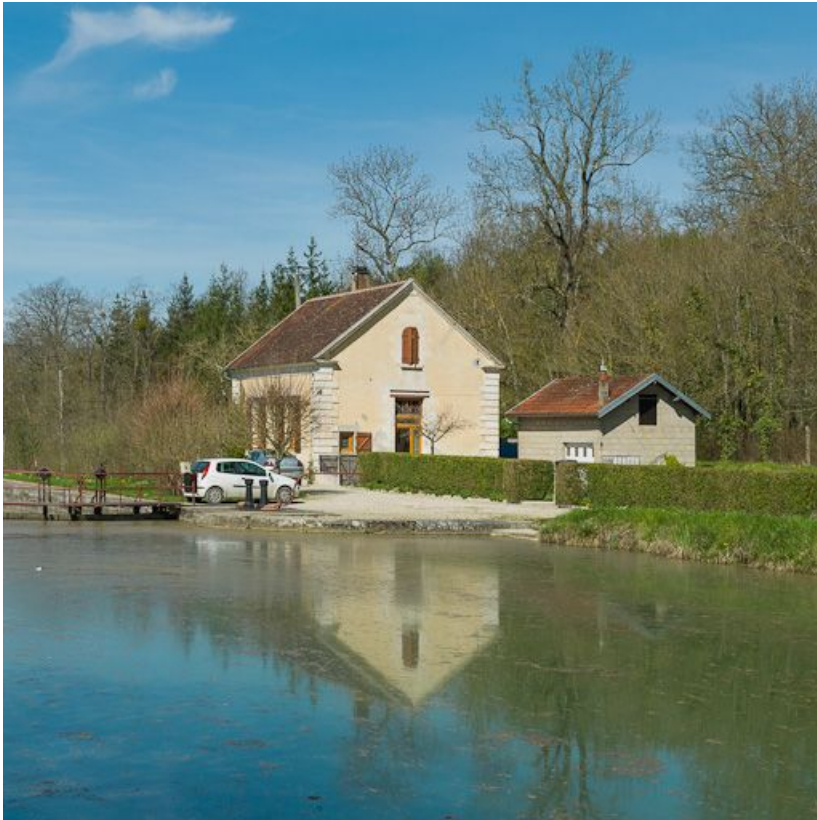
Maison éclusière avec son annexe.
