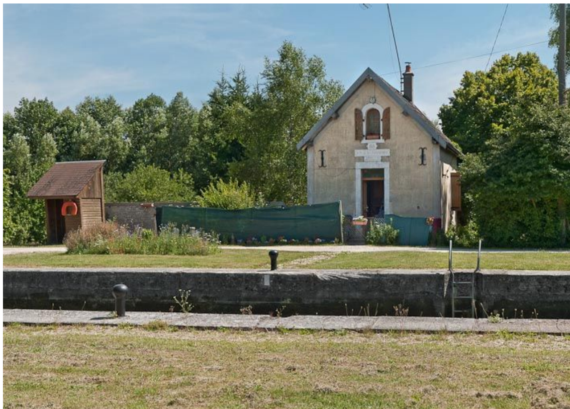
Vue d'ensemble du site d'écluse.
