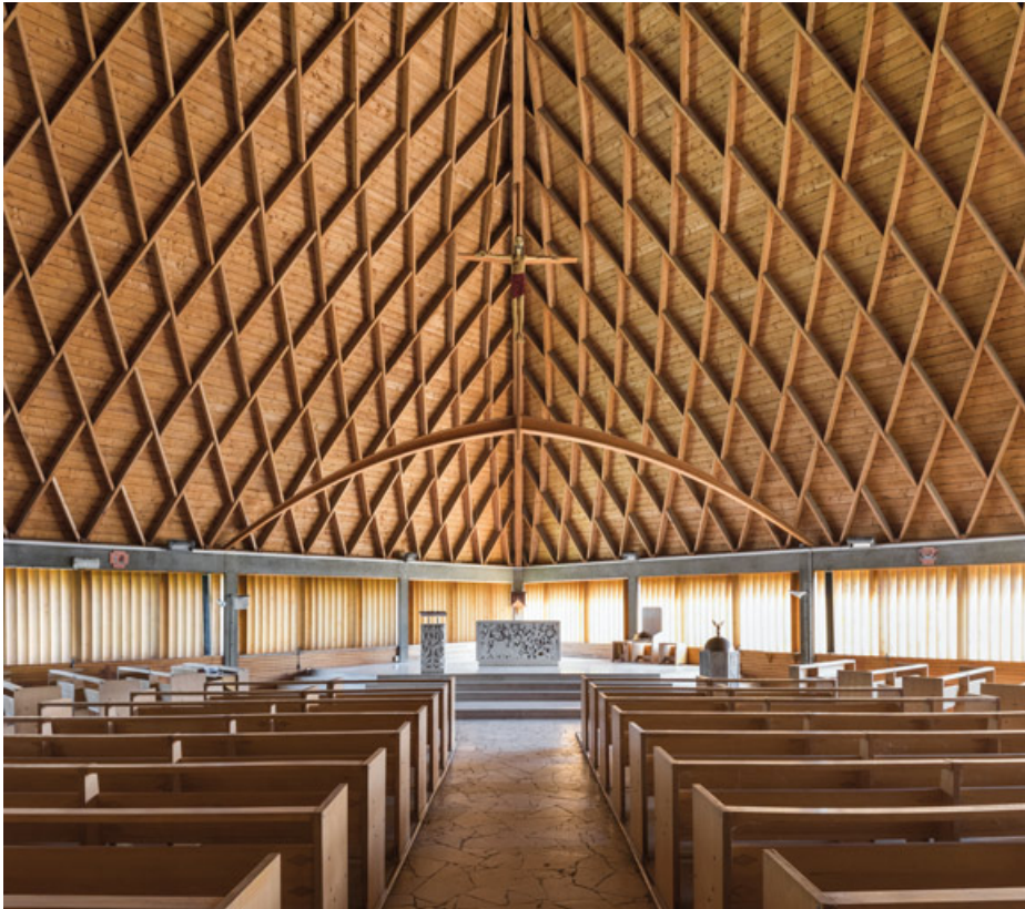
Chœur. Vue depuis l'allée centrale.
