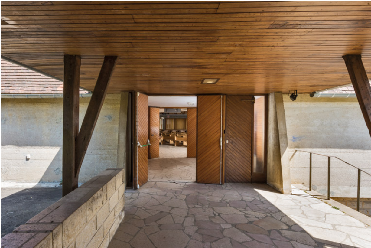
Entrée de l'église. Vue sous le porche.
