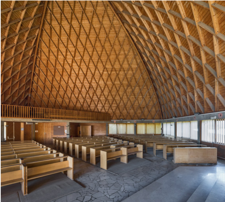
Nef. Vue en direction du nord-ouest.
