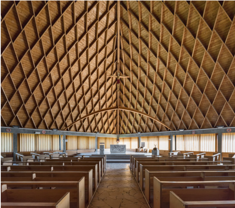
Chœur. Vue depuis l'allée centrale.
