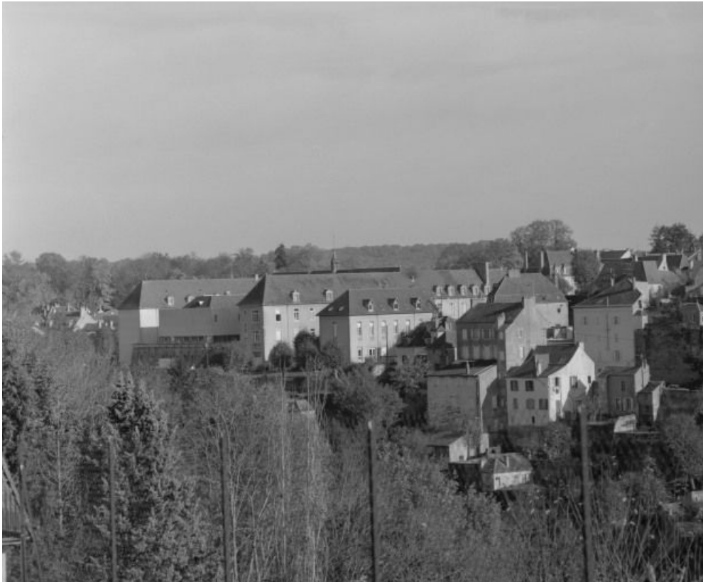
Vue d'ensemble, façade postérieure.
