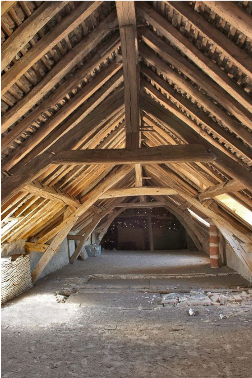
Comble et charpente du bâtiment sud.
