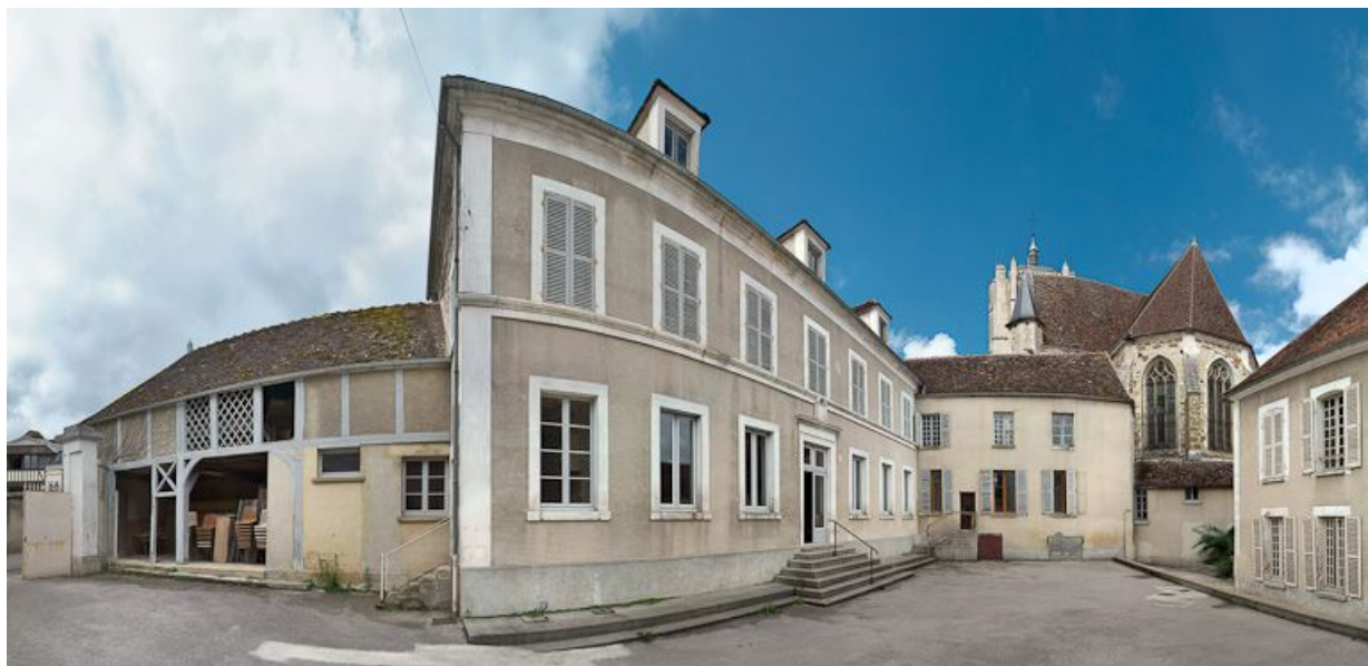
Vue d'ensemble des façades sur cour.
