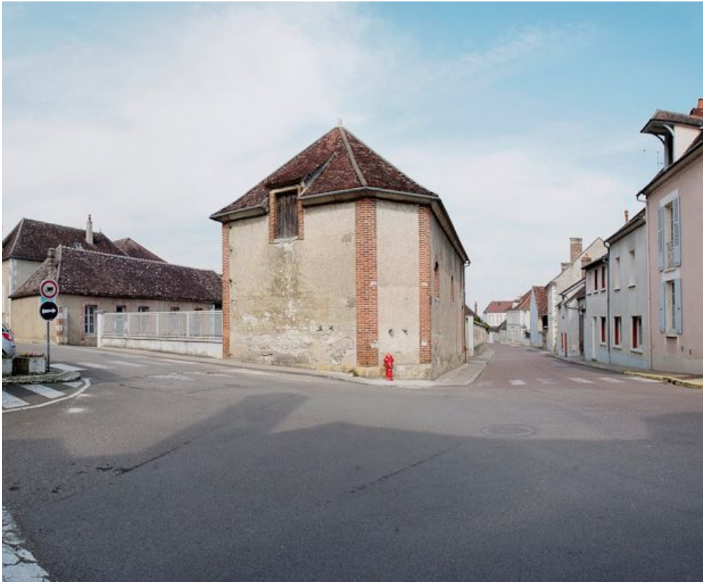
Anciennes dépendances, vue d'ensemble.
