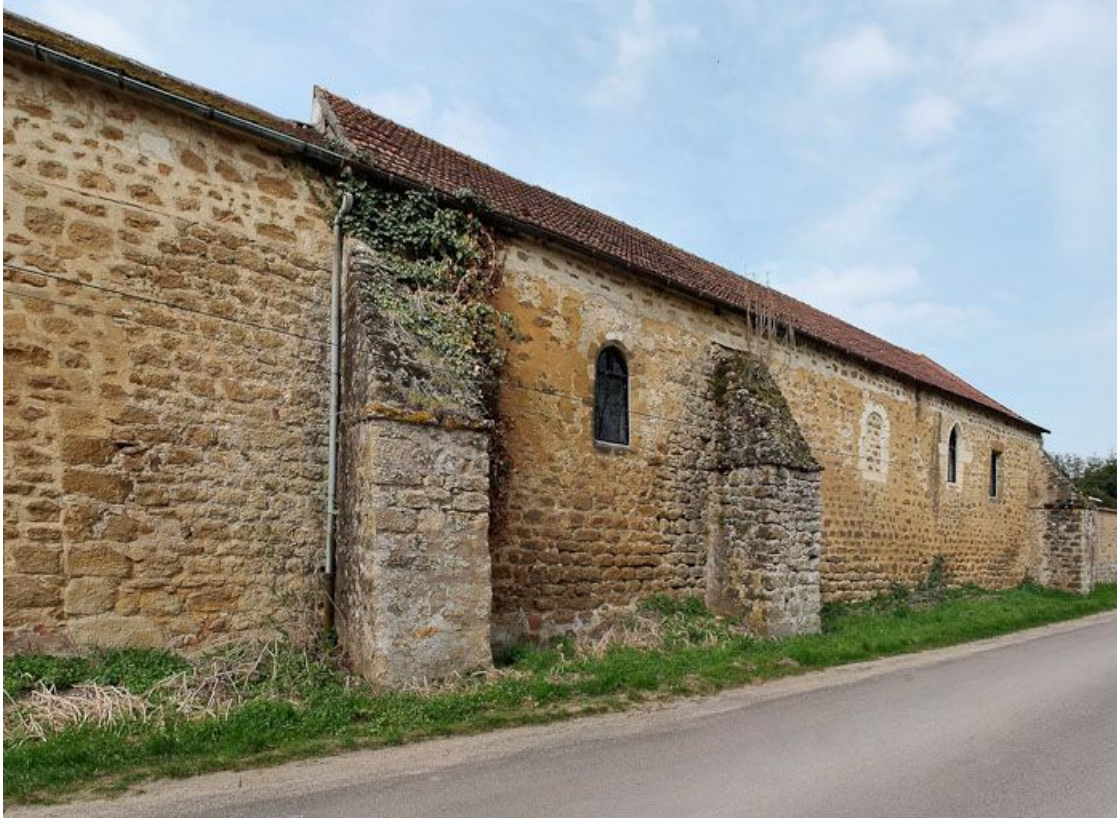
Chapelle : mur de long-pan sur rue.
