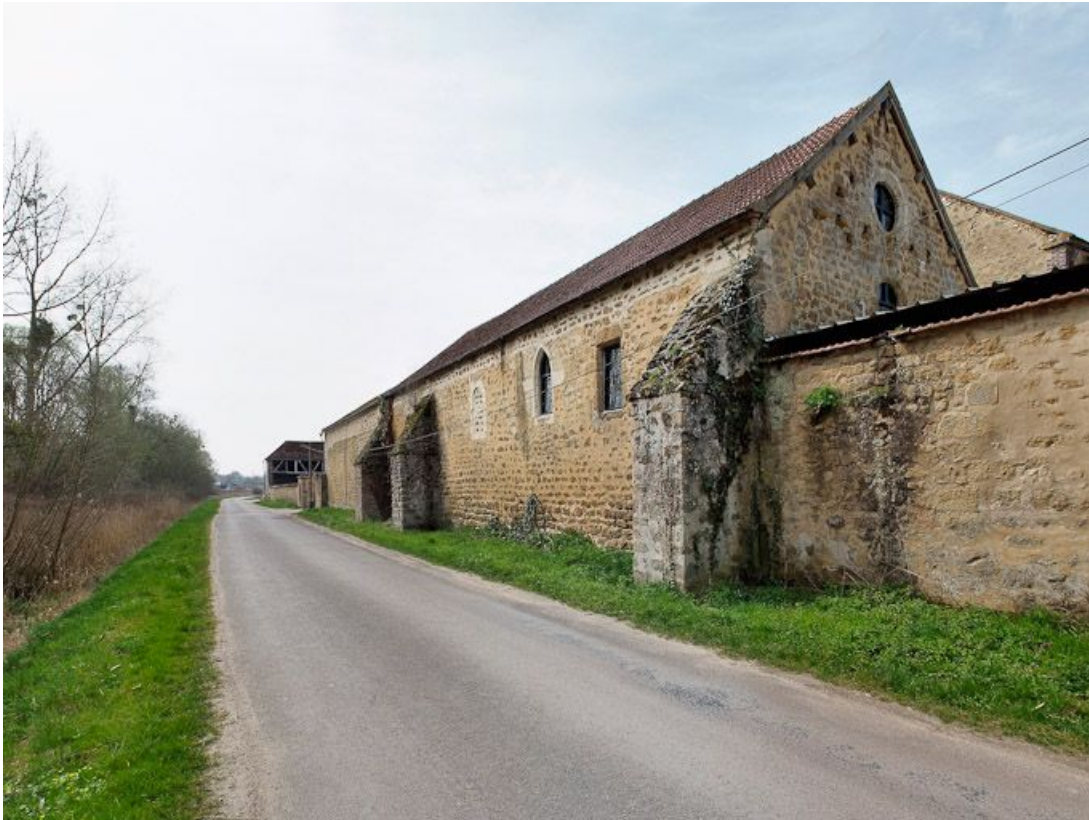
Chapelle, vue d'ensemble depuis la rue.
