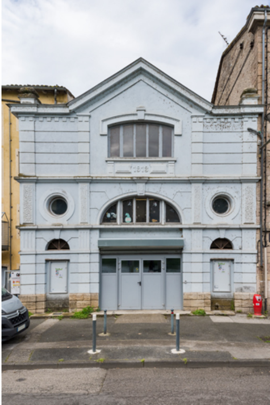
Façade postérieure, quai de Verdun.
