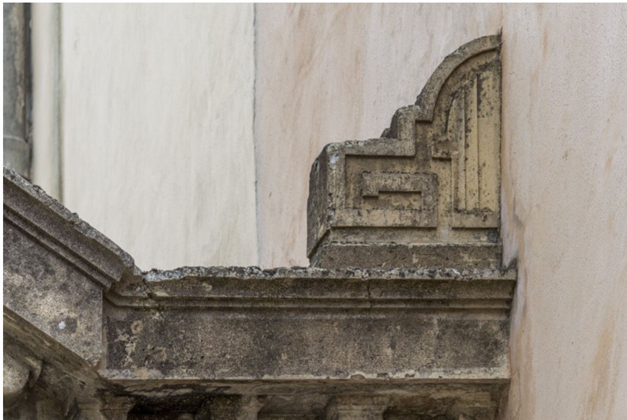
Façade antérieure : décor en partie supérieure.
