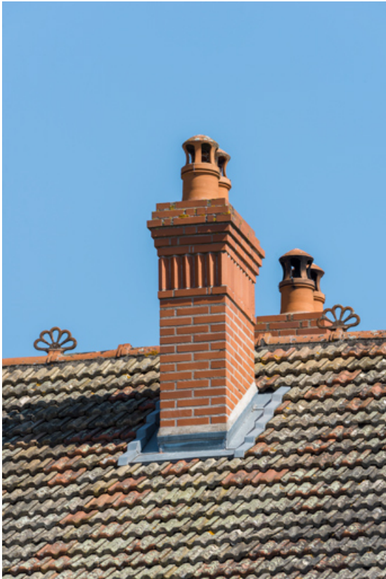
Hôtel-restaurant : souches de cheminée.
