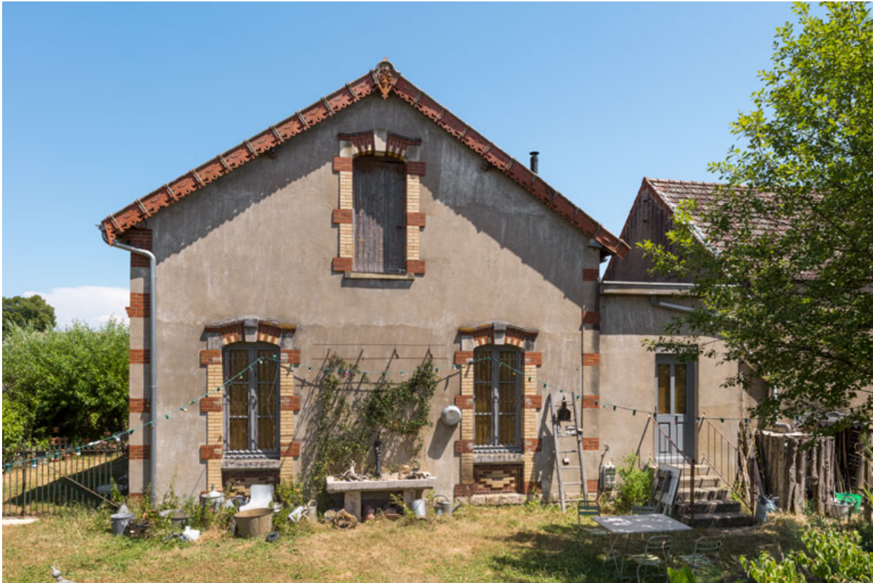
Salle de bal : façade latérale droite.
