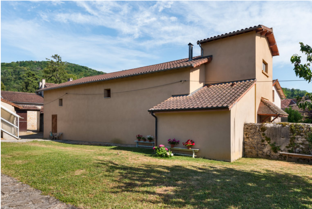
Façade latérale gauche, de trois quarts droite.
