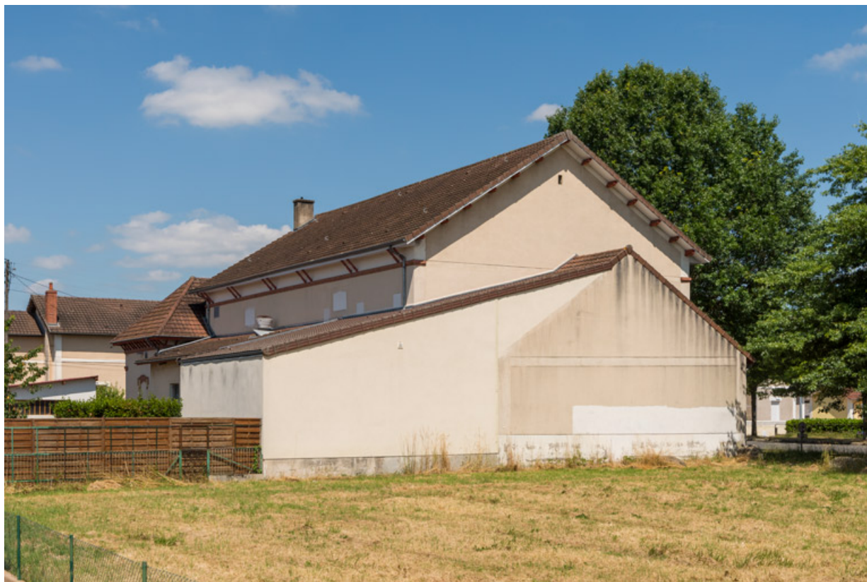
Façades postérieure et latérale droite.
