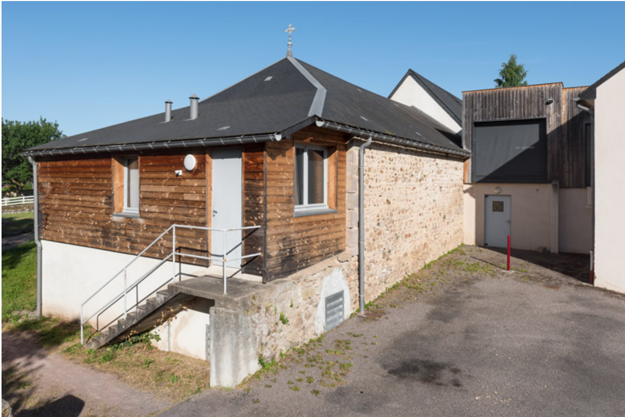
Façades postérieure et latérale gauche.
