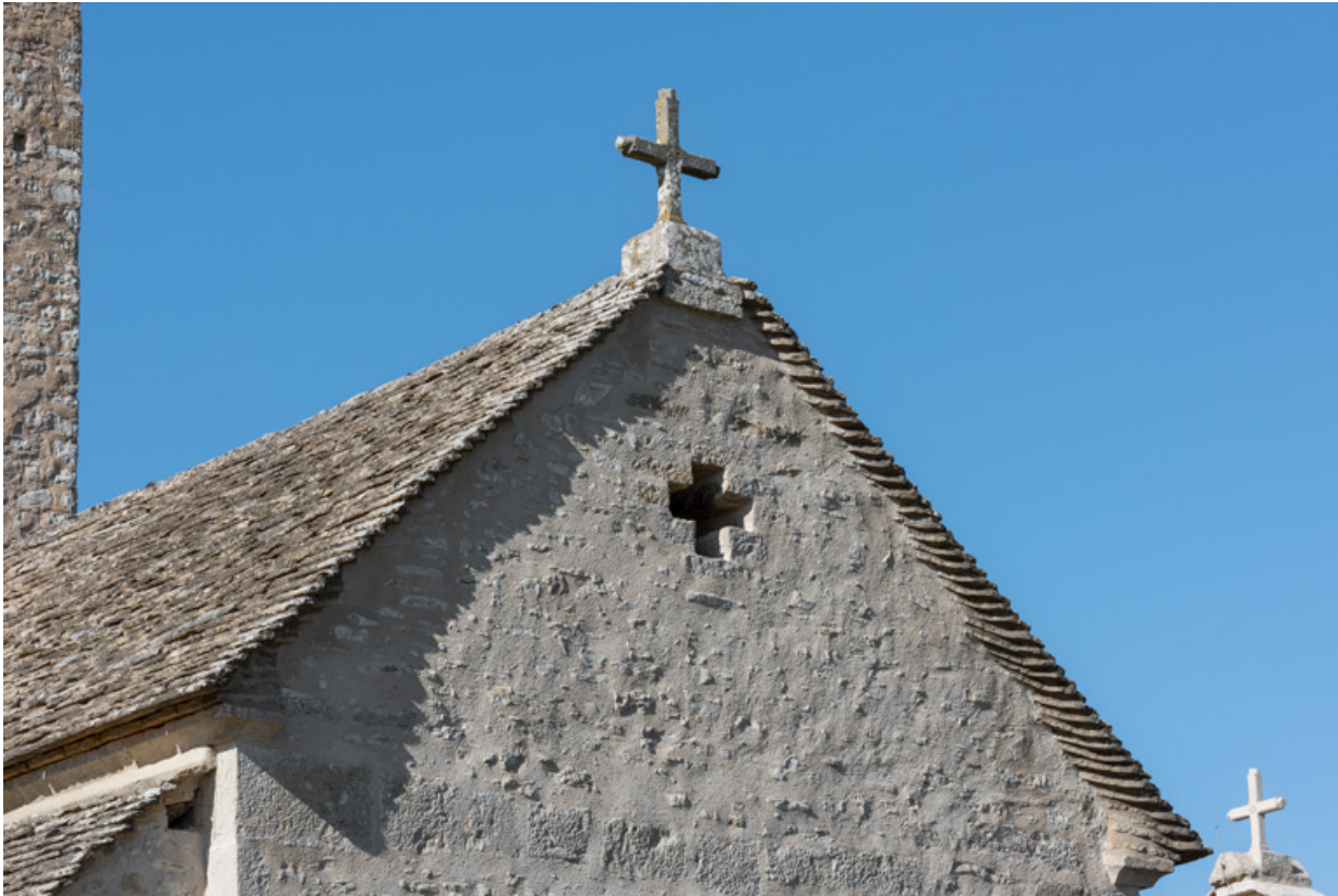
Pignon couvert de la façade.
