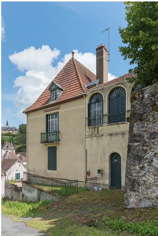
Vue depuis la rue de La Roche.
