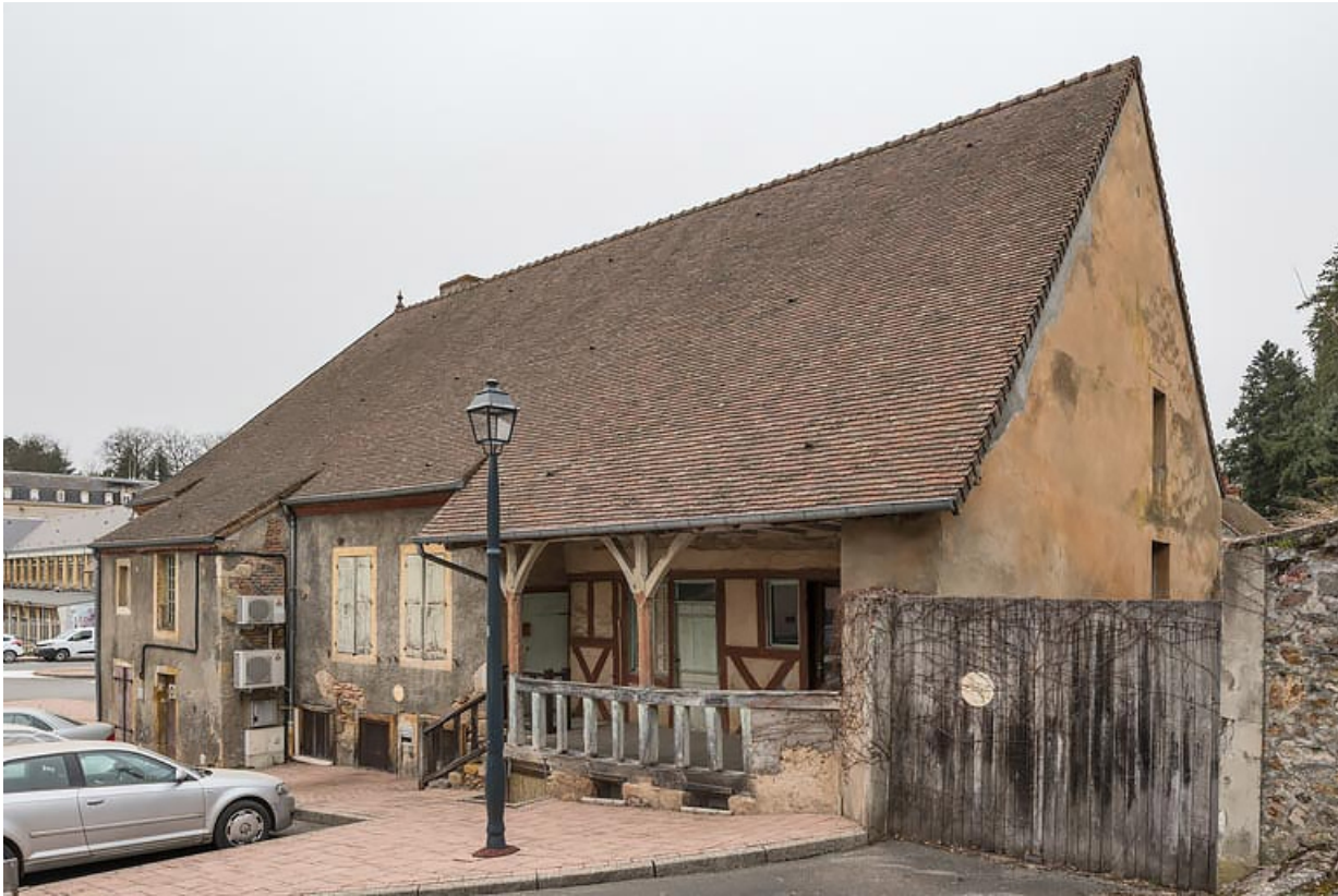
Vue actuelle depuis l'ouest.
