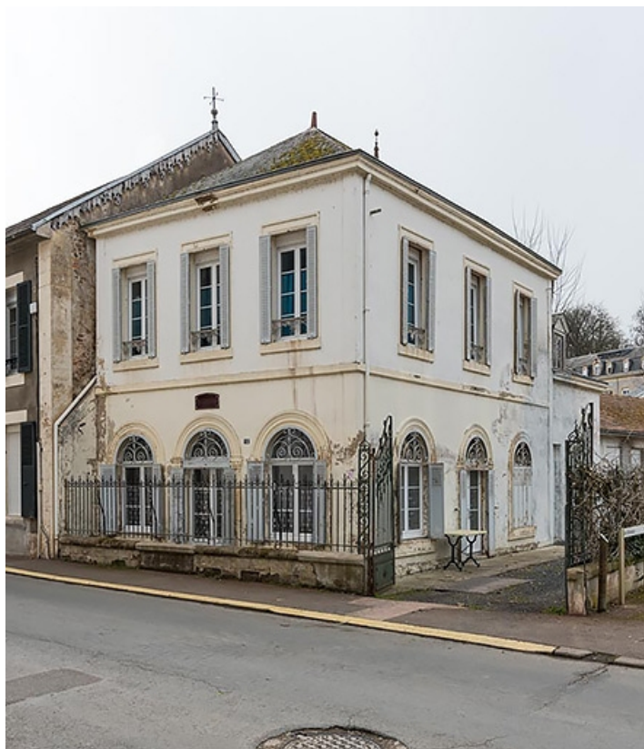
Façades sur l'avenue de la Libération.
