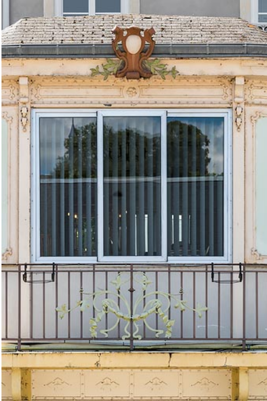
Aile ouest, salle à manger, détail.
