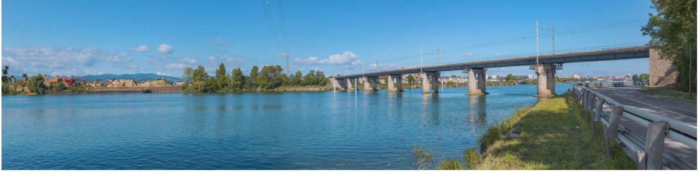
Le pont vu d'aval, rive gauche.
