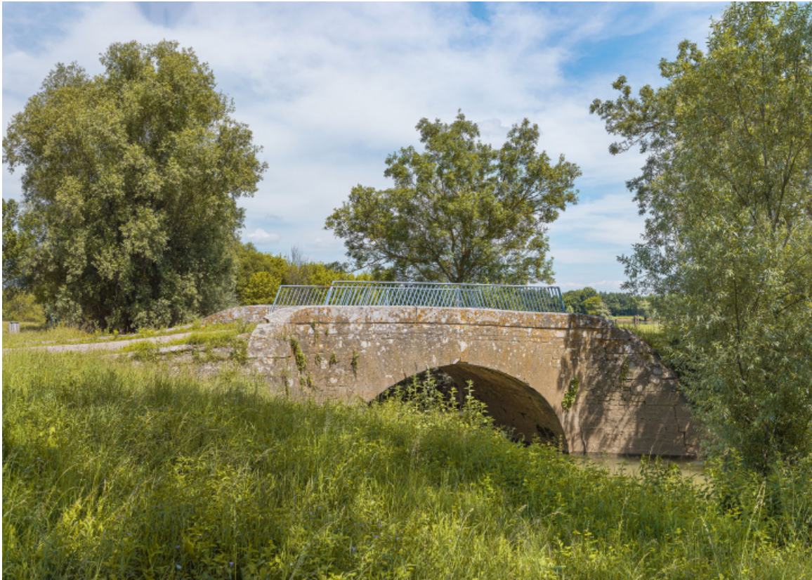
Vue d'ensemble du pont.
