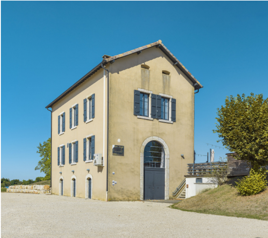
Pignon et façade postérieure de la maison.
