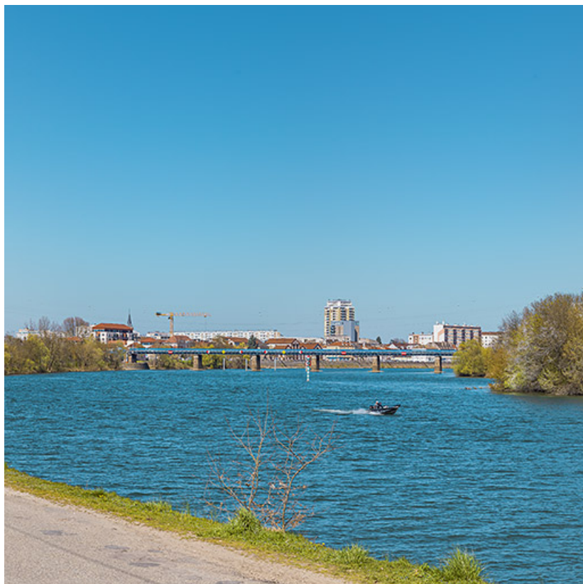
Vue d'ensemble du pont, depuis l'aval.
