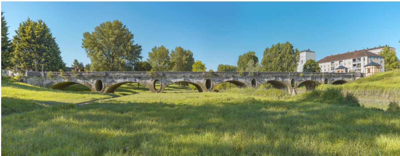
Vue d'ensemble du pont des Chavannes.
